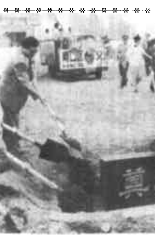
图为市领导为东营港口岸查验设施工程奠基。（徐兆鹏 摄）
